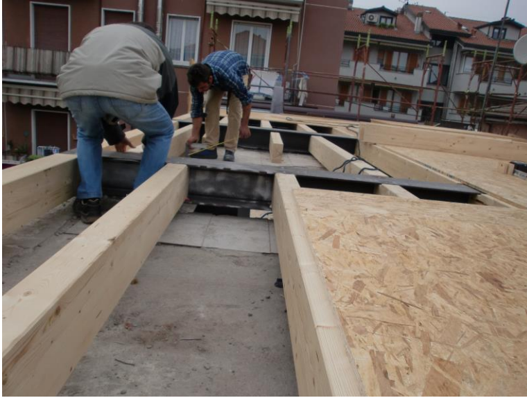
solaio in legno
