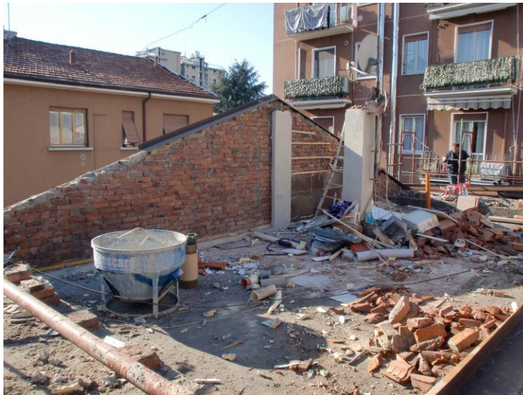
demolizione del sottotetto
